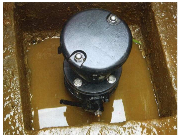
五八分水路：愛西市佐折町宮寺地内
